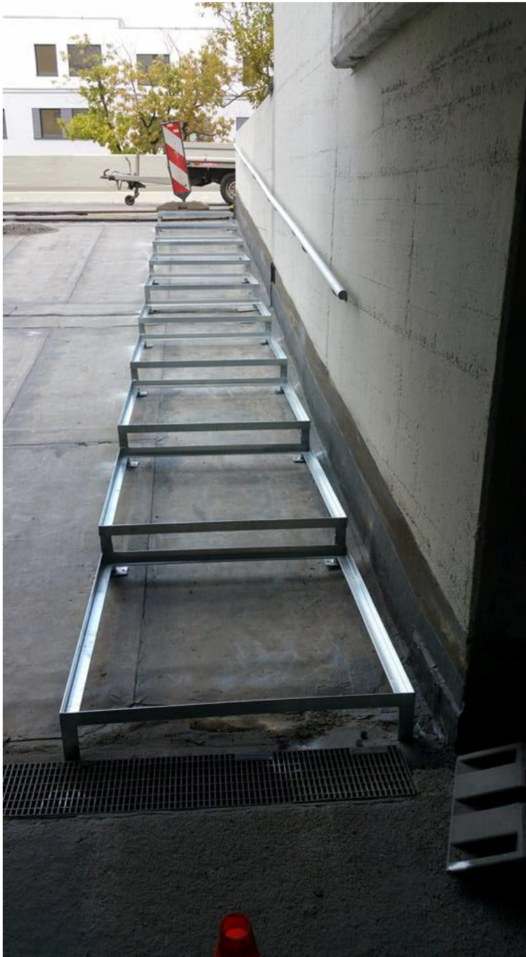
Winkelrahmen werden auf gedübelt zur Aufnahme der Gitterrosten
