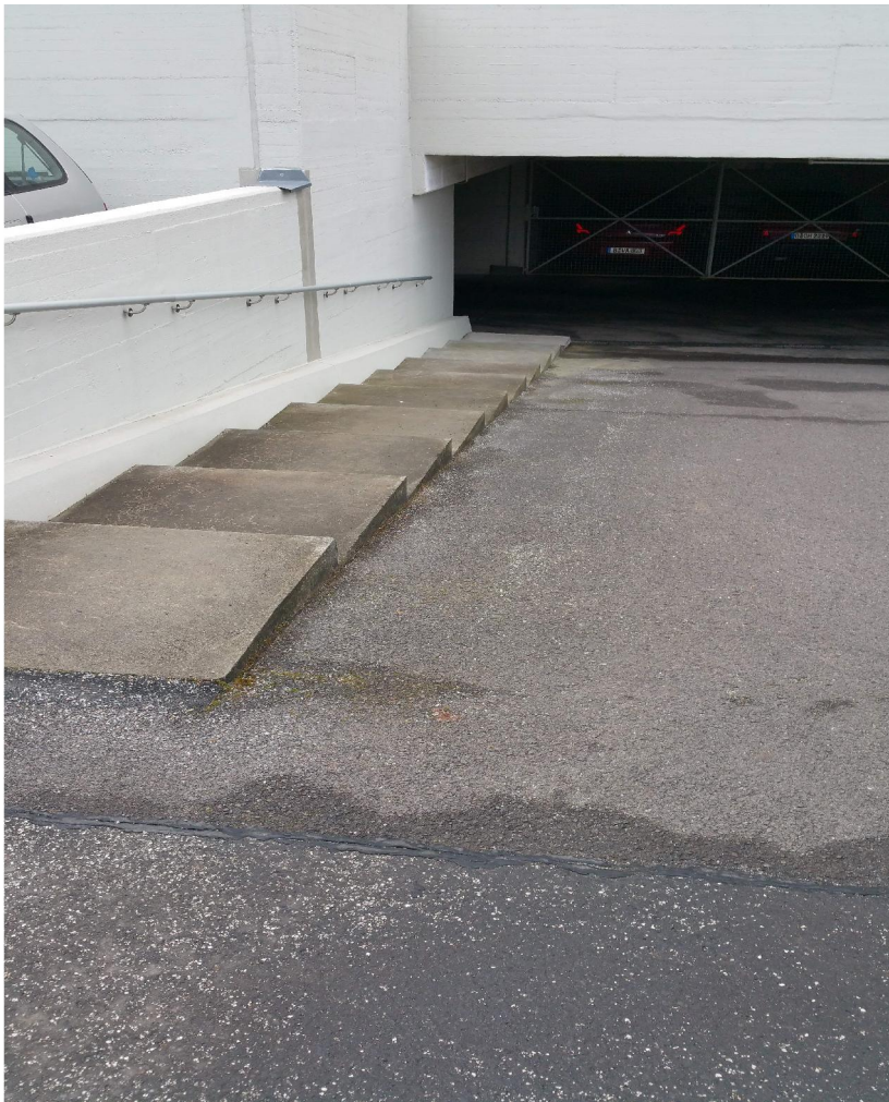
Vor der Baumaßnahme
