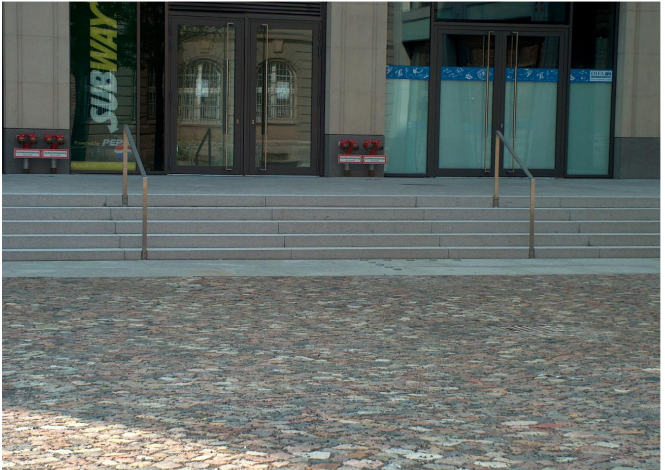
Außengeländer in den Granitstufen eingepasst
