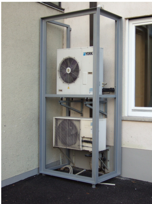
Aggregat Verkleidung mit Sichtschutz/ Wetterschutzlamellen Aluminium eloxiert
