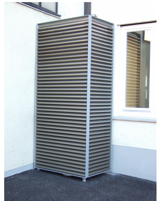
Aggregat Verkleidung mit Sichtschutz/ Wetterschutzlamellen Aluminium eloxiert
