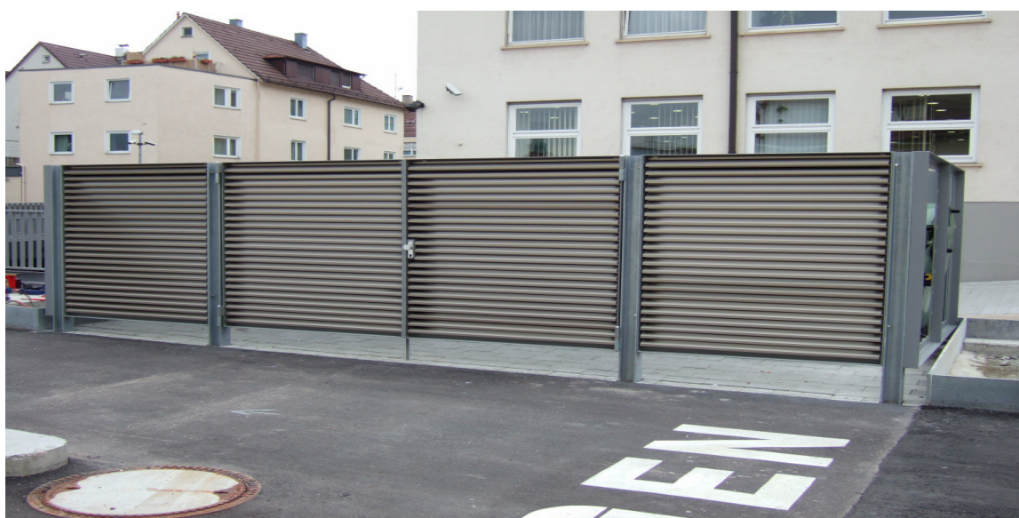
Müllplatzverkleidung mit Sichtschutzlamellen, Aluminium eloxiert
