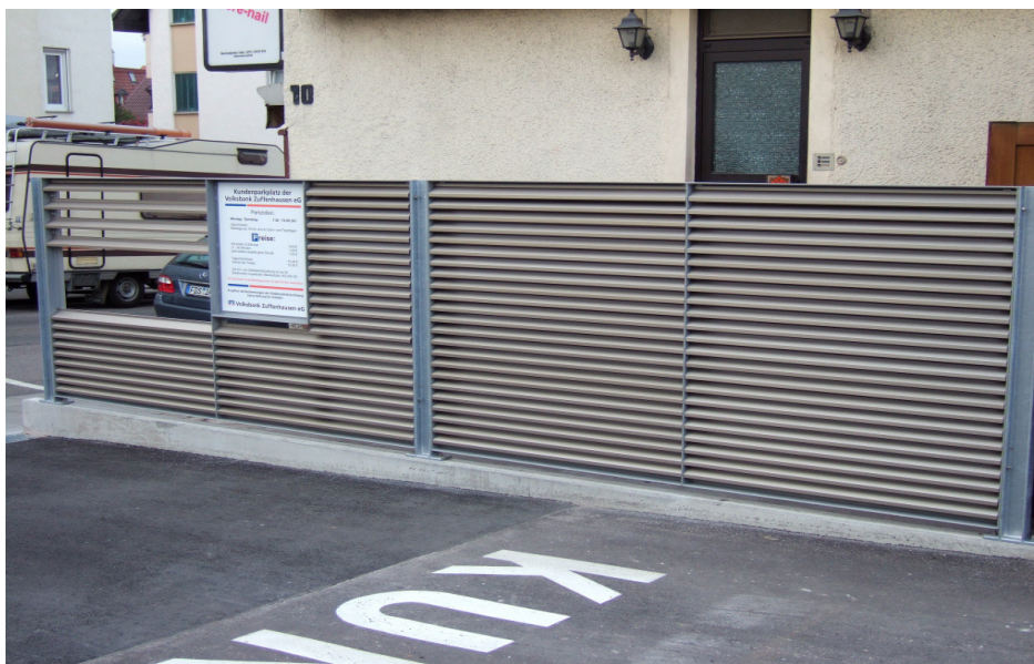
Sichtschutzwand zum Nachbarobjekt
