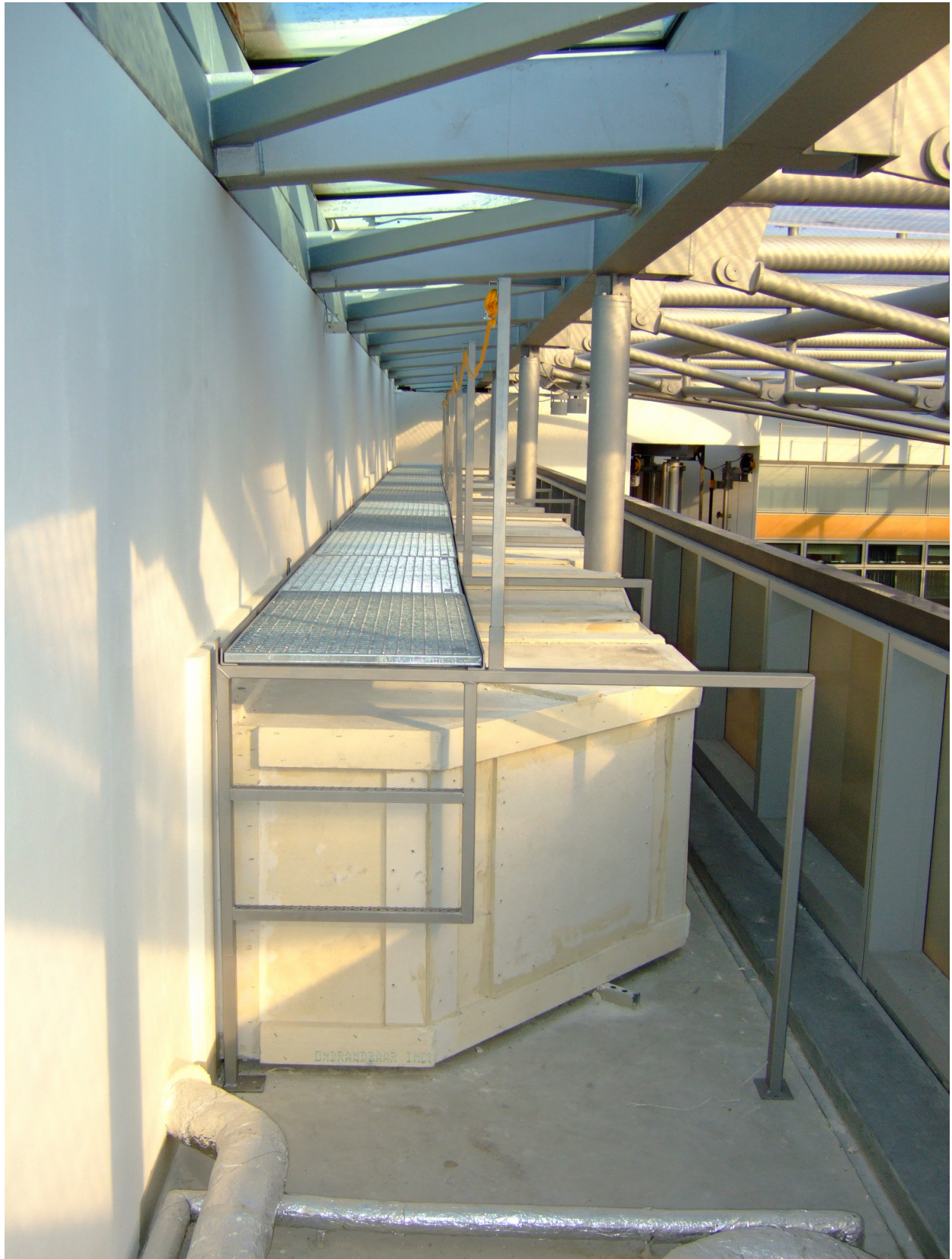
freitragende Konstruktion aus U-Bügeln mit Gitterrosten und Halteseilen, verschraubt und demontierbar
