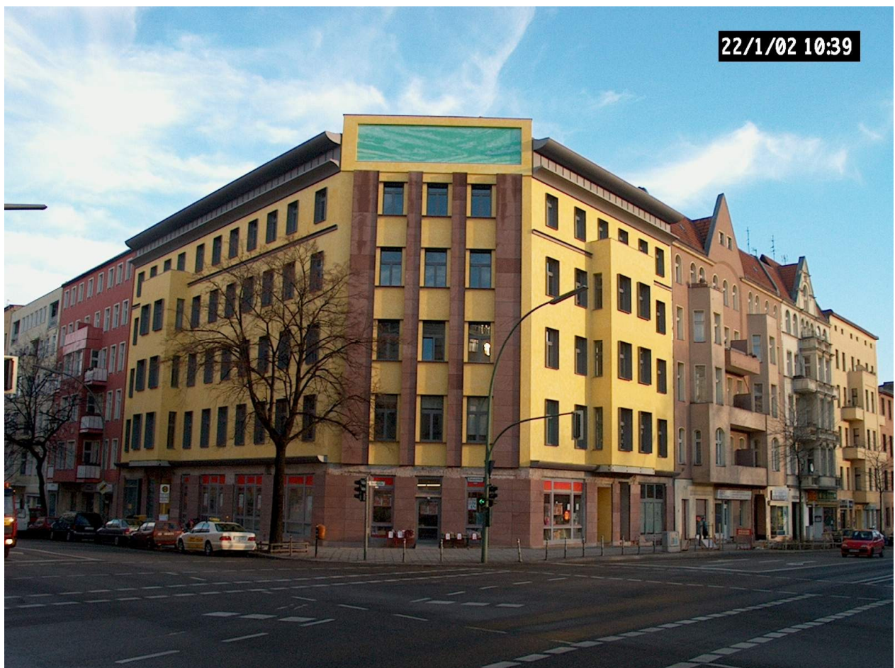
Objekt vor der Baumaßnahme
