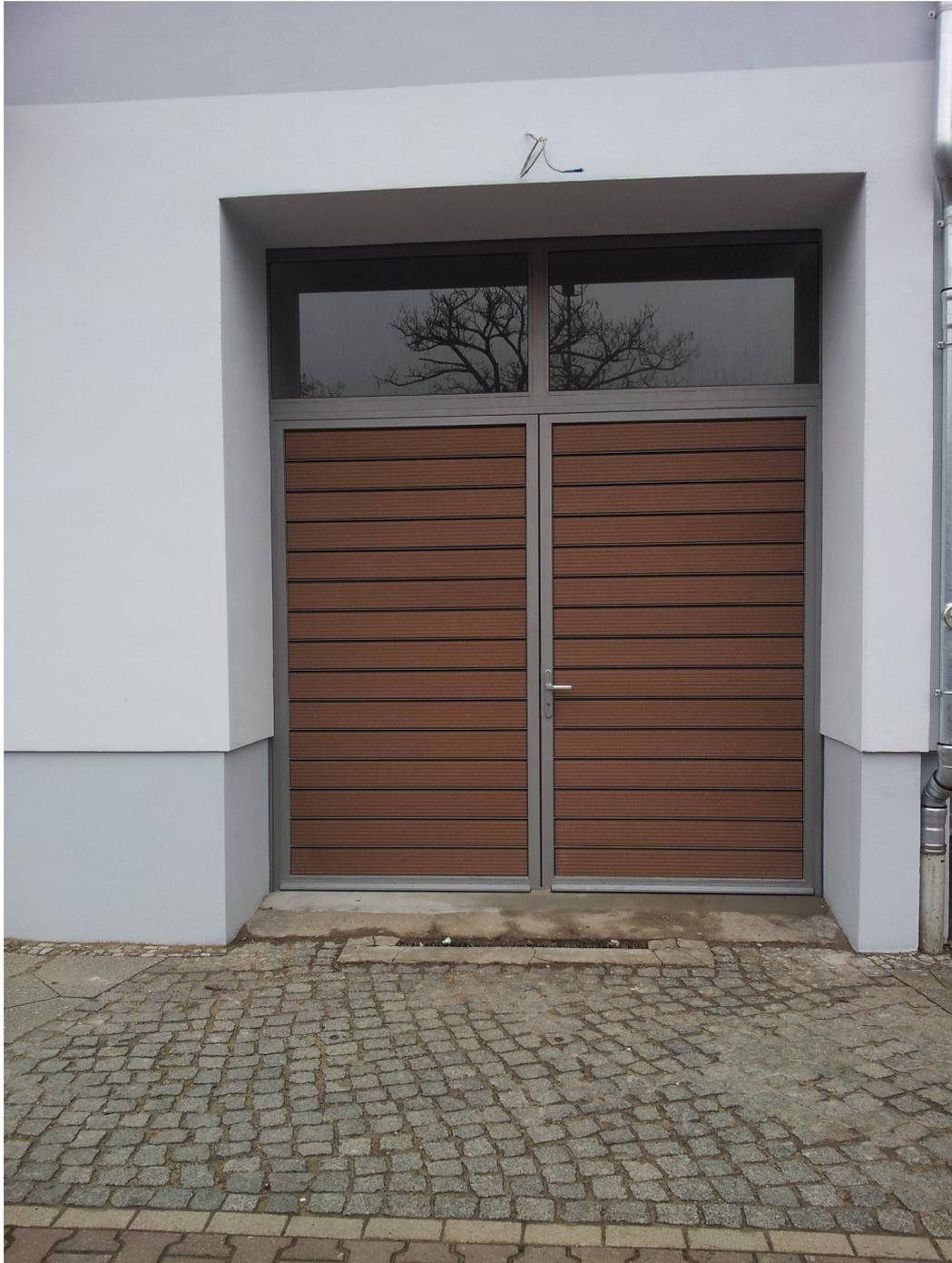
Lärmschutz inklusive, durch die Hohlkammerprofile, witterungsbeständig, leicht zu reinigen, verschiedene Farben sind möglich.
