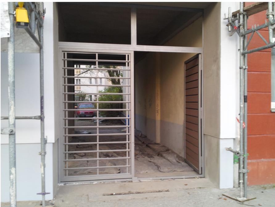
stabile Grundkonstruktion aus RR und T-Profilen mit eingeschraubten Hohlkammerprofilen
