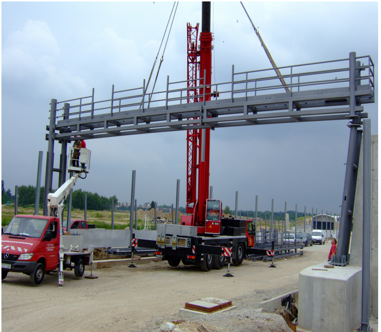
Aufsetzen der 1. Brücke und Bolzenverbindungen montieren
